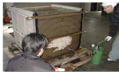
ドリル孔に注入プラグを取付け、圧入開始
