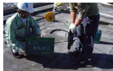
押さえ層に注入孔を穿孔
