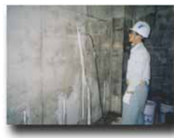
躯体裏面への注入状況 セパ穴から戻ってきている「G」
