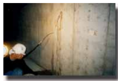
クラック注入状況
