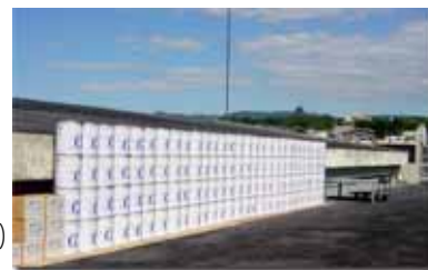
歩行用屋上スラブの全面リニューアル
