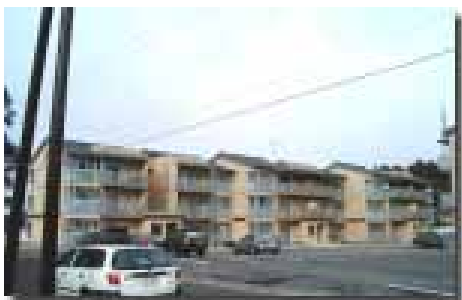
大沢野町住宅整備事業 笹津町営住宅(全躯体)
