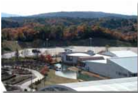
七尾フラワーパーク アルファー・ソル4地盤改良工法
