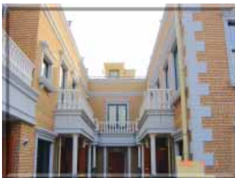
ラ・アトレ杉並松庵 アルファー・ゾル屋上防水仕様
