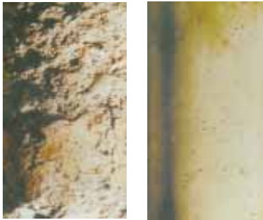
普通コンクリート アルファー・ゾル4 10kg/m 3 混入コンクリート
