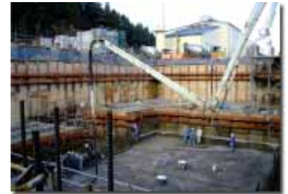
ごみ固形燃料化施設(石川県) 地下全躯体アルファ・ゾル工法
