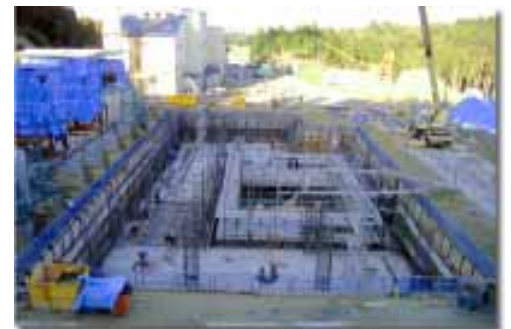
ごみ固形燃料化施設 (石川県) アルファ・ゾル地下躯体防水工法
