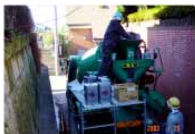
ラ・アトレ田園調布 アジテータ車への投入
