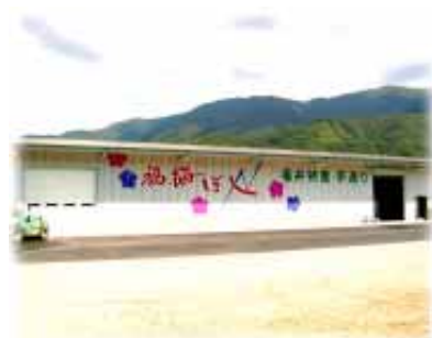
福梅工場 福井県 工場土間及び水槽
