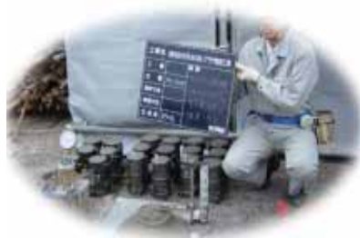
白石市ふれあいプラザ 現場受け入れ検査
