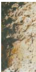
普通コンクリート
