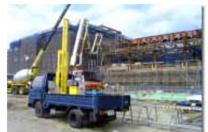
新県庁舎（石川県）
