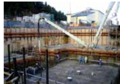
ごみ固形燃料化施設(石川県) 地下全躯体アルファードゾル工法
