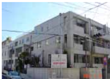
にじのもりハウス(名古屋) 地下駐車場・RFスラブ
