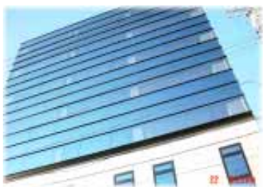
シーエヌ建設 (株) 本社ビル【名古屋市】 アルファ・ゾル屋上防水仕様 (SRC 造)
